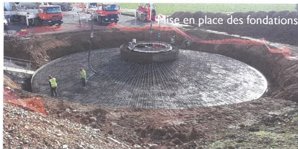
Figure 335 : Illustration de la mise en place de la fondation d'une éolienne
